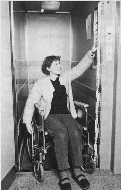
◀ Zum Beispiel Lift: Die Türbreite sollte mindestens 80 cm betragen; Flügeltüren sind für Rollstuhlgänger nur sehr schwer bedienbar. Sämtliche Bedienelemente sollten die Griffhöhe von 140 cm nicht übersteigen. Rollstuhlgängige Liftkabinen werden von führenden Aufzugherstellern standardmäßig angeboten.
