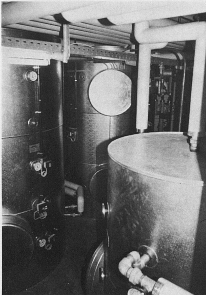
◀ Speicher und Kompressor der neuen Wärmepumpenanlage der Baugenossenschaft «Züri Leu» in Regensdorf. ▶
