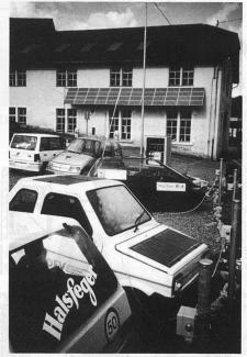
Solartankstelle beim Bahnhof Liestal. Die an die Fassade des abgebildeten Gebäudes montierte 2,4-kW-Photovoltaikanlage arbeitet im Netzverbund. Die parkierten Solar-Elektrofahrzeuge beziehen den Strom zum Laden ihrer Batterien entweder direkt von der Solaranlage oder bei schlechtem Wetter und in der Nacht vom öffentlichen Netz.
