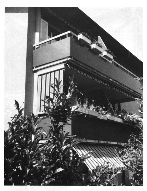
abgestellten Stützen benötigt. Dies bedingt als Voraussetzung jedoch allerdings Betondecken. Die Holzbalkendekken lassen diese Art von Konstruktion nicht zu.
