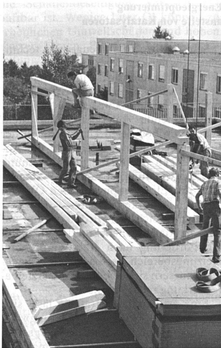
Zimmerleute beim Aufrichten von Stützen und Balken
