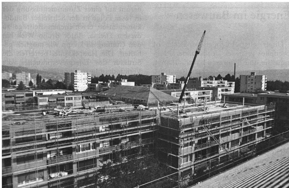
Eisenbetonarbeiten am Dachfuss
