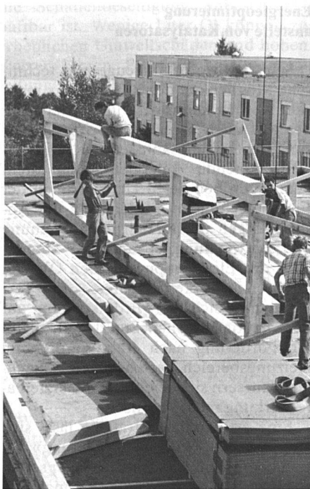
Zimmerleute beim Aufrichten von Stützen und Balken
