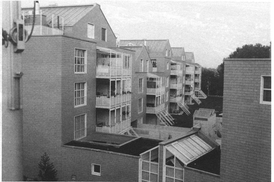
Ein Blick über die Siedlung zum bestehenden Quartier.
