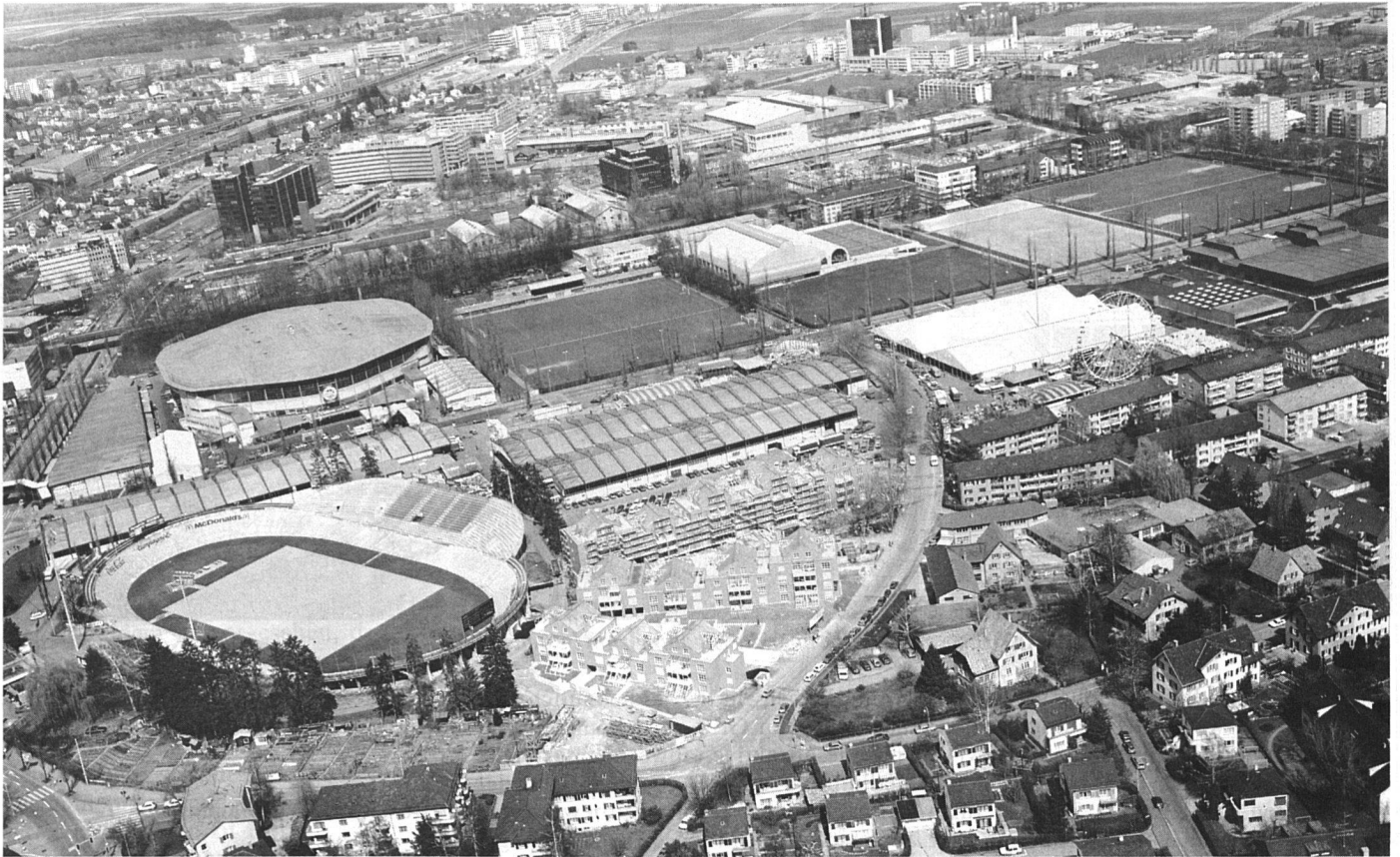
Die Siedlung Kirchenacker II versucht die städtebaulichen Kontraste zwischen kleinmassstäblichen Wohnungsbauten und isolierten Grossbauten zu mildern. Foto: Comet
