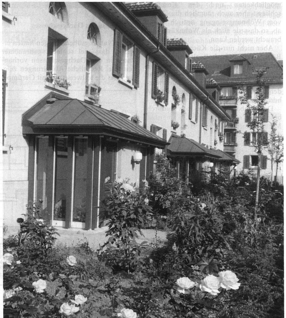
Unten: Angebaute Windfänge schaffen eine interessante Pufferzone zwischen innen und aussen. Foto: Karin R. Lischner
