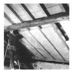
Fibriver, Schweizer Hersteller von Glasfasern, bringt ein neues Produkt für Wärme- und Schalldämmung zwischen Dachsparren, Deckenbalken und bei Ständerkonstruktionen aller Art (Holz oder Metall) auf den Markt. Es ist aus feiner kunstharzgebundener Glaswolle. *Uniroll* ist für nicht belastbare Wärmeund Schalldämmung im Bau bestimmt.
