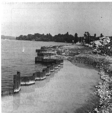
Oben und links: Die Räumung der Kies- und Betonwerke sowie Seeauffüllungen ergaben die Möglichkeit, weitere Uferstrecken für eine öffentliche Benützung zu gestalten. Unsere Bilder entstanden am Seeufer Tiefenbrunnen. Links eine fertiggestellte Partie.
