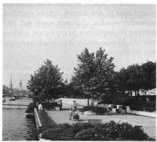
Bild oben: Die Oberflächengestaltung der in der vorstehenden Illustration als Querschnitt skizzierten Uferanlage ist urban mit vorfabrizierten Waschbetonplatten und mit gärtnerischen Mitteln aufgelokkert und durchgrünt (Utoquai Zürich, oberhalb des Opernhauses).
