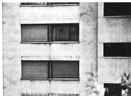
Die Sanierung beider «Krankheiten» geschieht auf die eine, wirksame Weise: Der schadhaften Aussenwand wird eine neue, wasserdichte und wetterfeste Aussenhaut vorgehängt. Das Wesentliche dieser Sanierungsmethode besteht in der Vorhängung. Diese bewirkt einen Luftraum zwischen Aussenwand und neuer Wetterhaut, der bei entsprechenden unteren Zuluft- und oberen Abluftöffnungen für die Abführung des Wasserdampfes sorgt, noch bevor dieser kondensieren kann.
