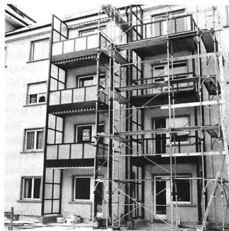
Die Balkone im Rohbau und vor der Fertigstellung.
