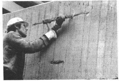
Freilegen von korrodiertem Bewehrungsstahl.
