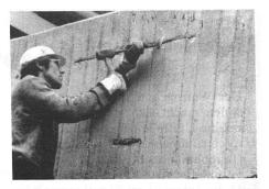
Freilegen von korrodiertem Bewehrungsstahl.
