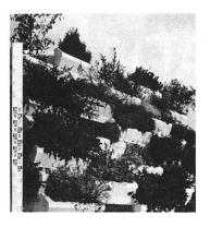
lebendiges Schattenspiel. Ein optimales Pflanzenwachstum ist gewährleistet. Zur Vereinfachung des Versetzvorganges ist der Stein mit Seitennocken versehen. Eine Böschungsneigung über 70° wird damit ausgeschlossen. Die Seitennocken verhindern das seitliche Abrutschen des eingefüllten Erdmaterials.
