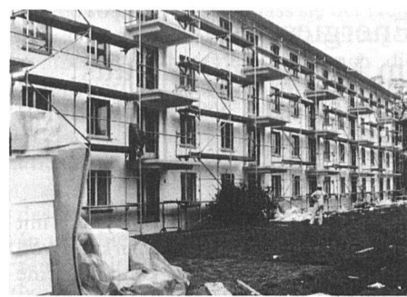
Starre Isolation während des Aufbaus (Baugenossenschaft Schönauf)
