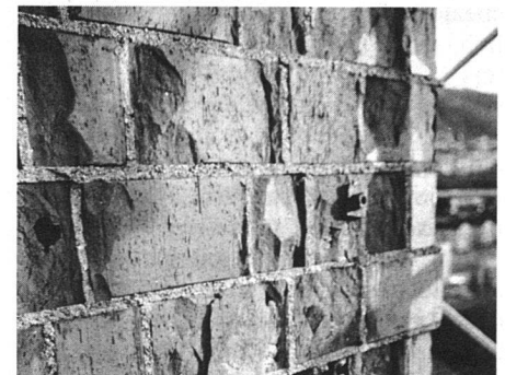
Durch mangelhafte Verarbeitung abgefrorenes Mauerwerk (unten)
