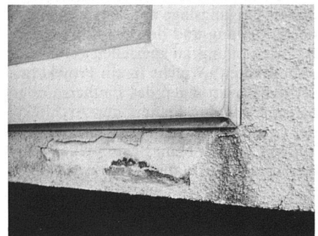
Bauschäden, hervorgerufen durch schlecht kombinierte verschiedene Baumaterialien
