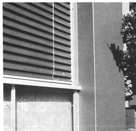
Aufbau einer vorgehängten Fassadenkonstruktion im Bereich Fensterbank, Rafflamellen und Leibung
