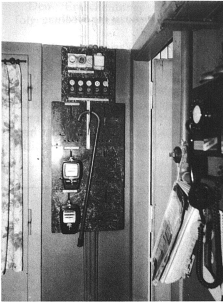
Die Elektroinstallationen sind nicht mehr vorschriftsgemäss.
