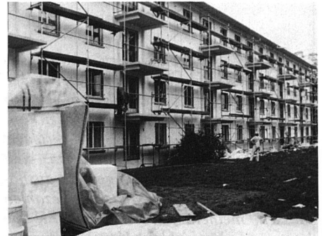
Teil der totalen Gebäudeisolierung: Fassadenisolation.
