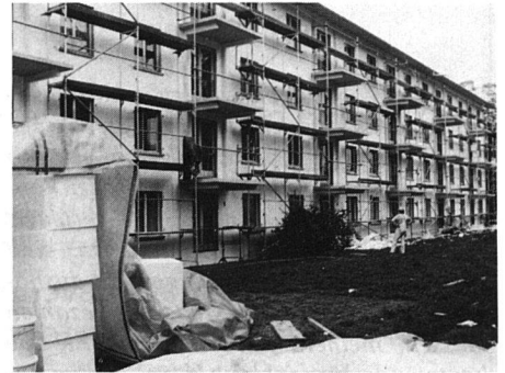
Teil der totalen Gebäudeisolierung: Fassadenisolation.
