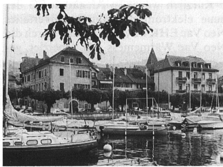
Altes Dorfkern der Gemeinde Lutry (VD Schweiz) wird mit Wärme aus dem Genfersee beheizt.
