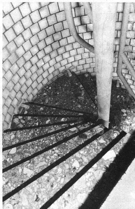
Das neue Treppenhaus: Wände Kalk-sandstein, Stufen Kunststein.
