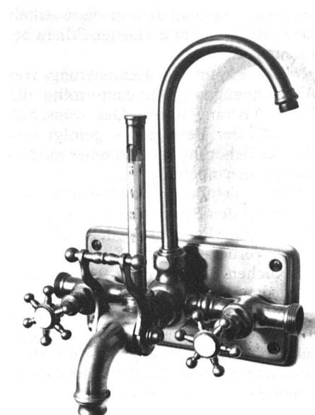
Unser Bild zeigt eine Warmwasser-Mischbatterie aus dem Jahr 1920.
