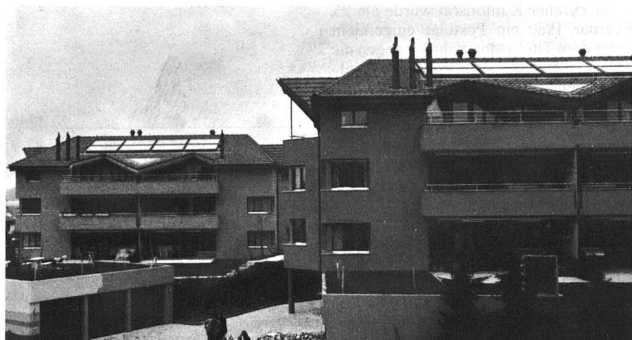
Mehrere «alternative» Energiequellen werden in dieser Siedlung genutzt. Auf dem Dach sind die Sonnenkollektoren erkennbar, unter der Garage wird das Wasser eines Baches gefasst und einer Wärmepumpe zugeleitet. Die Vereini-
