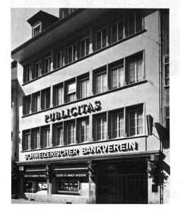
Altstadthaus in Winterthur Holz/Metallfenster, Sprossen aufgesetzt, Isolierglas durchgehend, Metallteile weiss einbrennlackiert.
