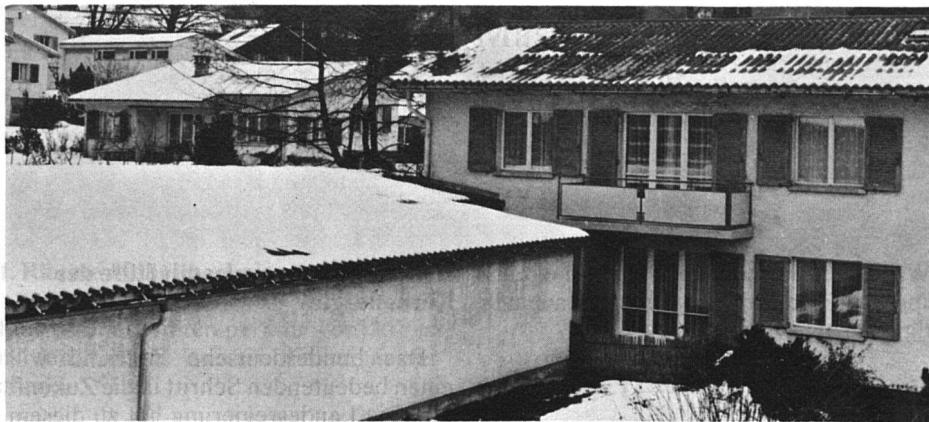
Swiss Photo rechts befindlichen Hauses lässt einen starken Wärmeabfluss vermuten. Dieses Haus ist offenbar thermisch nicht genügend isoliert - die kostengünstige Wärmeverschwendungsanwendung ist in der Kompaktheit und Kostenwirksamkeit von Vorteile.
