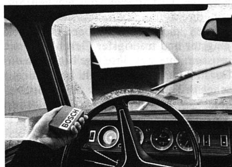
Noch mehr Komfort bietet die PTT-geprüfte Funkfernsteuerung, die für zusätzliche Fr. 390.- angeboten wird. Dank dem 2-Frequenzverfahren ist die Steuerung absolut fremdschalt sicher. Die Reichweite des Handsenders beträgt ca. 6-12 Meter, somit kann das Garagentor bequem vom Auto aus ferngesteuert werden.
