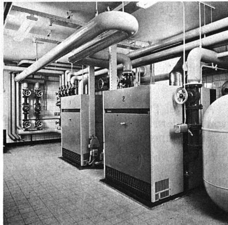
gasförmigen und flüssigen Brennstoffen eignen, hat nun zusätzlich einen international anerkannten Atmosphären-Gaskessel in ihr Verkaufsprogramm aufgenommen. Es handelt sich hierbei um den Remeha-Gusskessel, welcher bisher von der Firma von Roll vertrieben wurde.
