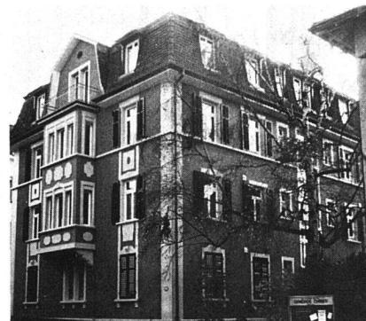
Das Haus Minervastrasse 118 in Zürich wurde von der Unirenova AG Zürich innert vier Monaten innen und aussen total renoviert. Bei dieser Renovation wurden Küchen und Bäder modernisiert, sind neue, doppelverglaste Fenster eingepasst worden und wurde das Dach neu gedeckt. Zugleich erhielten alle acht
