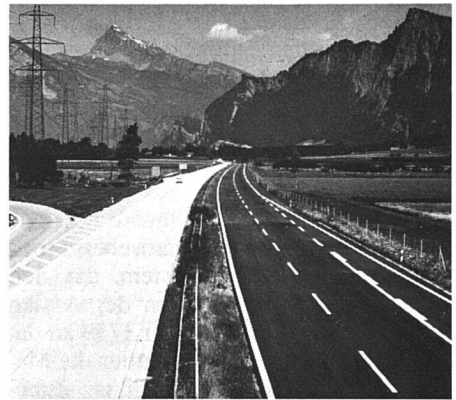
Jeder Autofahrer kennt den Unterschied zwischen einer hellen Autobahn mit Betonbelag und einer schwarzen Autobahn mit Asphaltbelag. Auf der Fahrt von Zürich nach Chur ergibt sich dieses Bild.
