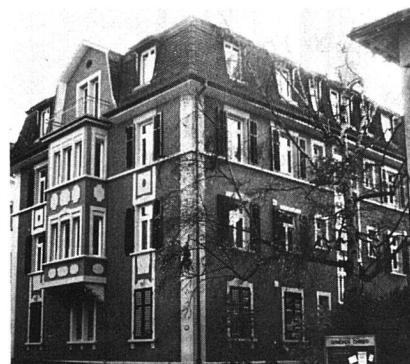
Das Haus Minervastrasse 118 in Zürich wurde von der Unirenova AG Zürich innert vier Monaten innen und aussen total renoviert. Bei dieser Renovation wurden Küchen und Bäder modernisiert, sind neue, doppelverglaste Fenster eingepasst worden und wurde das Dach neu gedeckt. Zugleich erhielten alle acht
