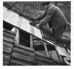
Die Betonziegel AG, Zürich, führt seit kurzem eine ganz neue Dachisolation in ihrem Verkaufsprogramm. Dieses neue Thermodach bietet eine optimale und wirtschaftliche Lösung für die maximale Wärme-Isolation und zwar für Alt- wie Neubauten. Es ist dies ein schuppenartiges Unterdach aus Kunststoffelementen, das auf die bestehende Lattung verlegt und direkt mit dem Ziegeldach eingedeckt wird. Dabei können bei Umdekkungen die bestehenden Lattungen und Ziegel wieder verwendet werden.
