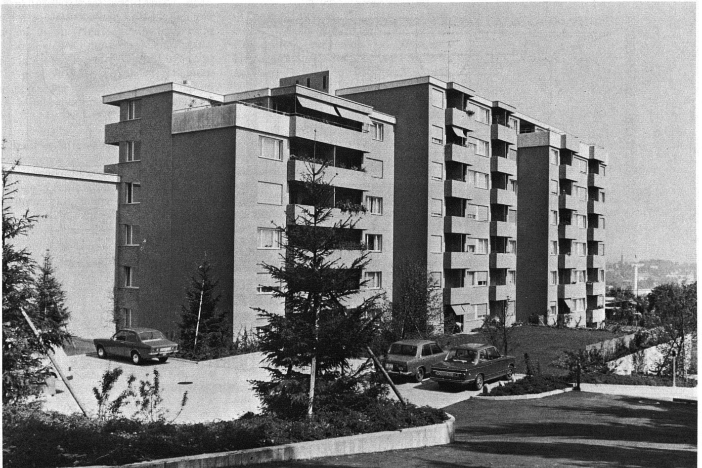
Unten: Ansicht des Hauptkomplexes von Süden
