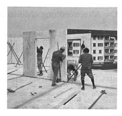
wänden und einer vorgehängten, nichttragenden Aussenwand (Schottenbauweise). Es basiert auf einem horizontalen Planungsraster von 380 × 270 cm. Das Konstruktionssystem – Montagebau in Betongrosstafelbauweise – umfasst nur 7 typisierte Bauteile für die tragenden Aussen- und Innenwände und 2 typisierte Bauteile für die Decken. Das maximale Gewicht des grössten Bauteils beträgt etwa 3,7 Tonnen.
