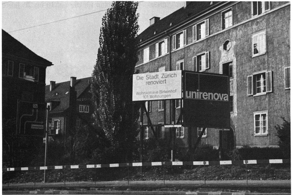
Renovieren statt demolieren: Siedlung Birkenhof
