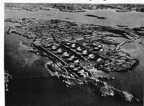
tanks von total 1,2 Mrd. Liter (1 Mio. t) Gesamtkapazität über 7 Rohre verbunden, von denen die zwei grössten 1,07 m Durchmesser haben und durch die ein Tanker in 22 Stunden seine Ladung von 397 Mio. Liter Öl entleeren kann.
