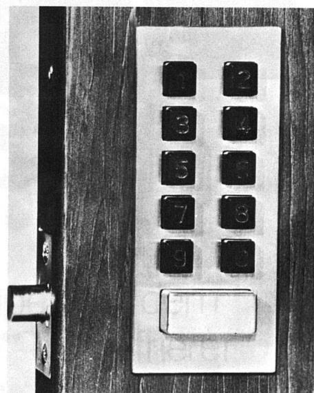
in der richtigen Reihenfolge die Stellung erreicht wird, in welcher der Riegelmechanismus zurückfahren kann. Falls man aus irgendwelchen Gründen eine neue Zahlenkombination wünscht, können die Zahnstangen jederzeit leicht gewechselt werden.
