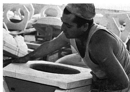
Aufsetzen der Abdeckplatten
