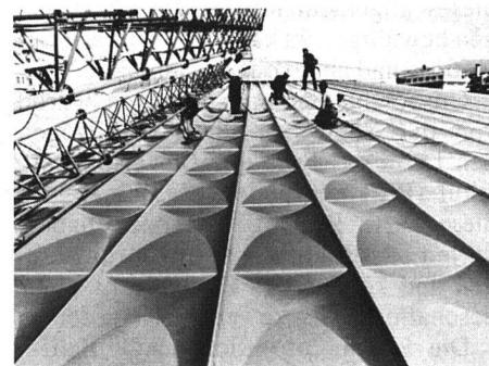
Unser Bild zeigt die Montage einer GFK-Bedachung eines Sportstadions. Durchmesser: 160 m.
