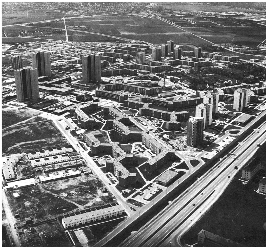
Die Photos auf dieser Seite vermitteln einige Impressionen des riesigen Baugebietes von Mannheim-Vogelstang
