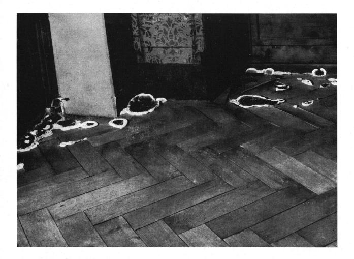
Wachstum benötigten Stoffe. An der Holzoberfläche flechten sich flaumige Mycelstränge und Rasen zusammen. Dann wird der Überzeugung polsterförmig und weiss. Aus diesen Mycelpolstern wachsen wiederum weisse, dünne Stränge, die bis zu 10 Millimeter Dicke anwachsen können.
