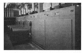
Unser Bild: Allg. Baugenossenschaft Luzern, Etappe «Himmelrich». Installiert ist eine Ygnis-Kessel-Boiler-Kombination, bestehend aus vier Kesseln, Modell NAN, mit je 1,4 Millionen kcal/h und zwei Warmwasserboilern. Die Brenner sind mit Schallschluckhauben ausgerüstet.
