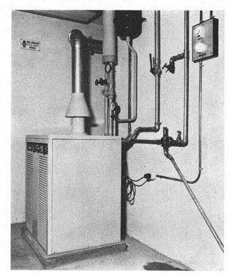
Leistungen können erzielt werden, indem zwei oder weitere Durchlaufheizer in Serie oder parallel installiert werden.
