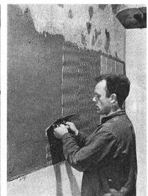
Vorgefertigte Elemente aus keramischen Wandplatten
