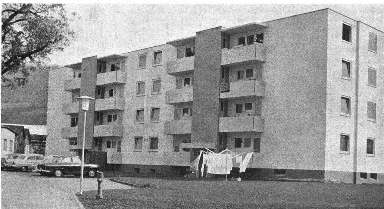
Die Umfassungswände der Wohngeschosse wurden mit Isoliersteinen 18 cm stark gemauert und zur Erreichung einer einwandfreien Isolation inwendig mit Duplexplatten 7 cm stark hintermauert. Alle Geschosstüren sind aus Eisenbeton; die Geschosstreppen aus Kunststein; die inneren Scheidwände aus Backsteinen, Zellton oder Gipsplatten. Das Flachdach erhielt eine Isolation aus 4-cm-Korkplatten und das landesübliche Kiesklebedach.
