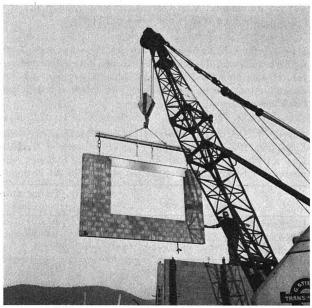
Das Pretonsystem auf Backsteinbasis ermöglicht es auch kleineren und mittleren Bauunternehmern, sich die Vorteile der Elementbauweise zunutze zu machen.
