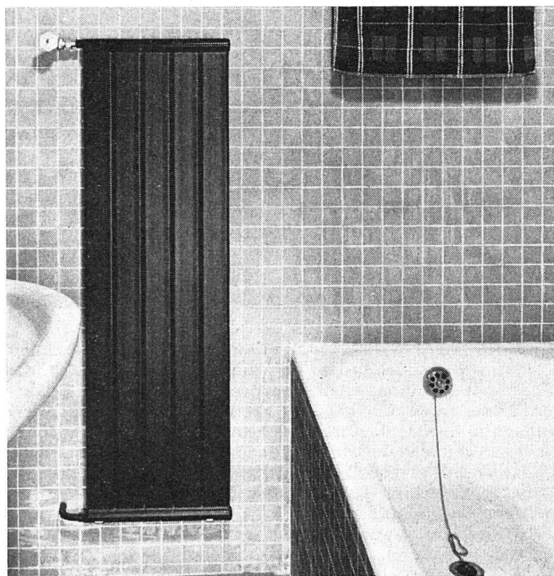
Für das Badezimmer ist als Wärmequelle die Heizwand zu empfehlen – vor allem wegen der milden Wärmestrahlung und der guten Reinigungsmöglichkeit. Weitere Vorteile: elegante Linienführung, platzsparend. (Runtal-Heizwand, Typ H.)
