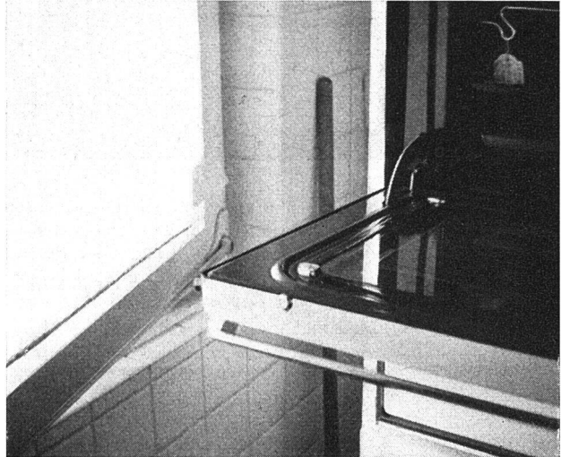
Der Fensterflügel und die Backofentüre behindern sich gegenseitig. Früher oder später scherbelt es ...
