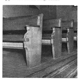
Elektrische Kirchenheizung mit Infrarot-Bankstrahlern, System Accum
