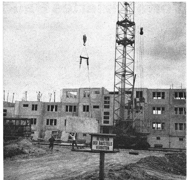
Montage von vorfabrizierten Bauelementen in Wien
