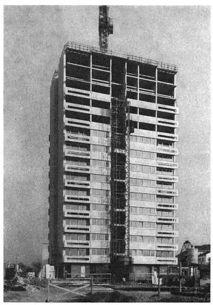
Die Schalungselemente können mit Hilfe von Spindeln so genau gerichtet werden, daß weder Fugen noch Rippen entstehen. Gegen die Mauern und Decken sind sie mit Sperrholz abgedeckt. Wände und Decken werden dadurch glatt und müssen nicht verputzt werden. Für die Behandlung durch den Maler oder den Tapezierer sind sie fertig.
