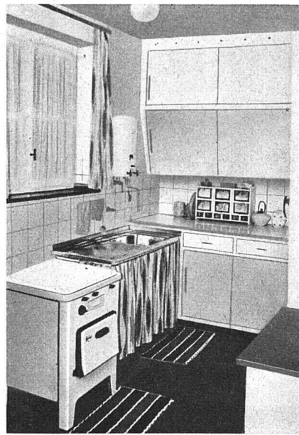
Zwei Küchen nach dem Umbau
