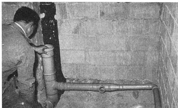
Das Verlegen von Hart-PVC-Ablaufrohren System Symadur/Anger (Photo Notz & Co. AG)
