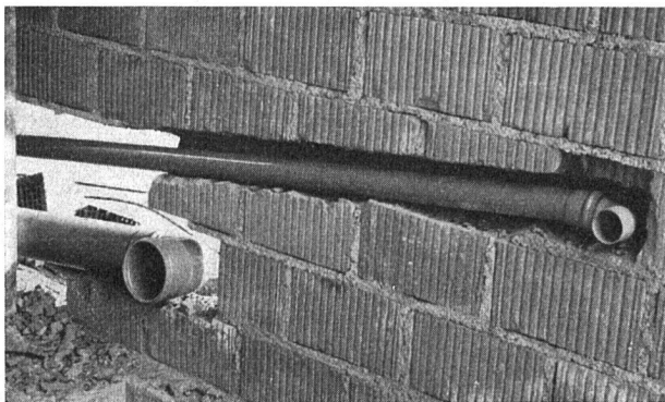
Beispiel einer Verlegung von Hart-PVC-Ablaufrohren (Photo Notz & Co. AG)
