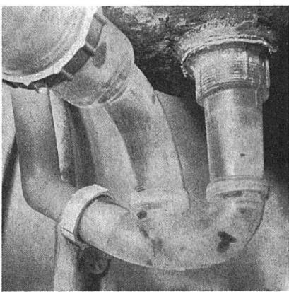
schrifte gemacht worden. Die bisher verwendeten Typen hatten den Nachteil, daß der Ein- und Auslauf den gleichen Durchmesser hatte und im Siphonbogen zudem eine ablaflörende Putzschraube eingesetzt war.
