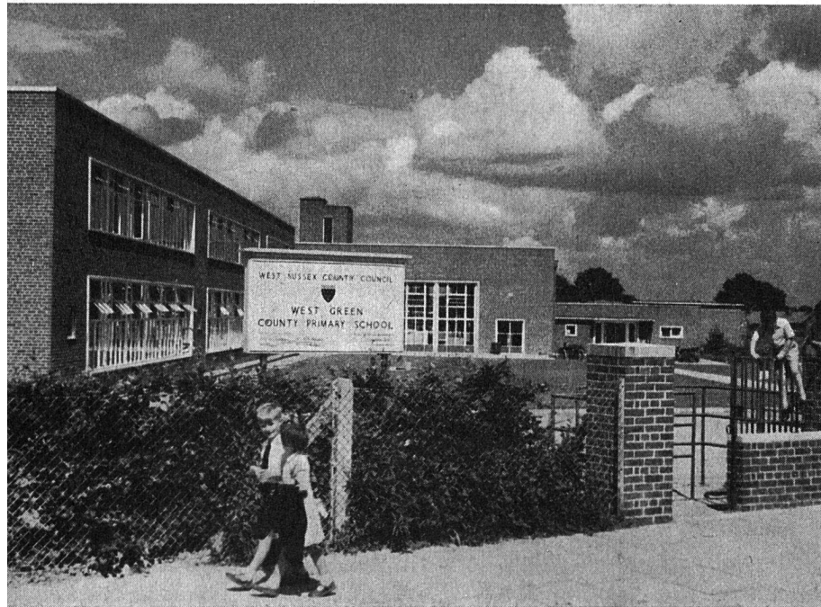
Beispiel einer Primarschule. Hier wurde der in England beliebte Klinker-Backstein für das Mauerwerk verwendet.
