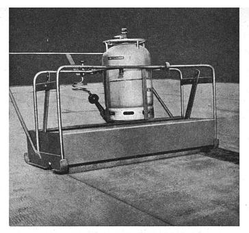
Das Eigengewicht des Apparates preßt die Dachisolierbahn auf die untere Lage
